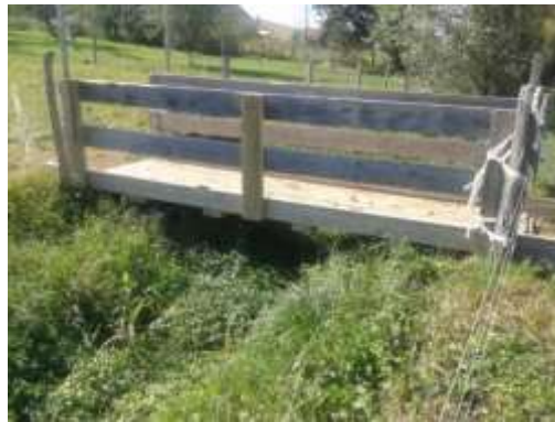
Exemple de passerelle en bois pour la traversée d'animaux
