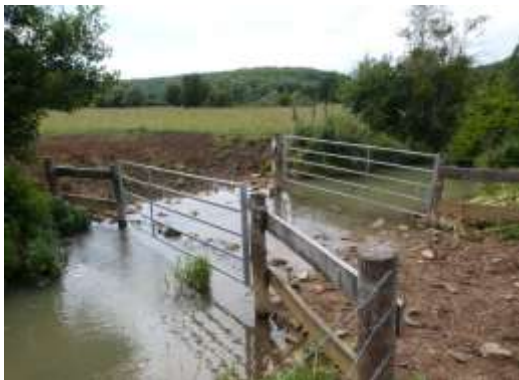
Exemple de portails mobiles permettant la traversée du lit (IER).
