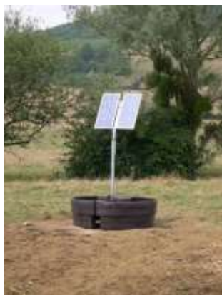
Exemple d'installation d'une pompe à panneaux solaires installée sur un puits
