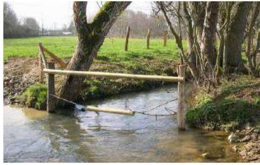
Exemple de clôture avec lisse semi-flottante (SIRTAVA, 2007)
