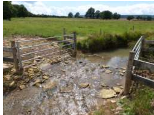
Exemple de portails mobiles permettant la traversée du lit (IER).
